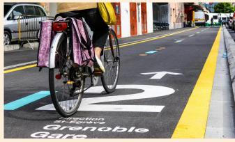
La Métropole a voté en 2017 un réseau de pistes cyclables structurantes. Un axe Grenoble-Meylan avait été défini pour permettre une liaison rapide, confortable et sécurisée (piste cyclable de 3 mètres de large séparée de la circulation automobile).
